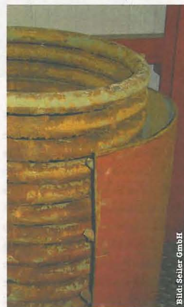
Ein Wasserboiler im Querschnitt
